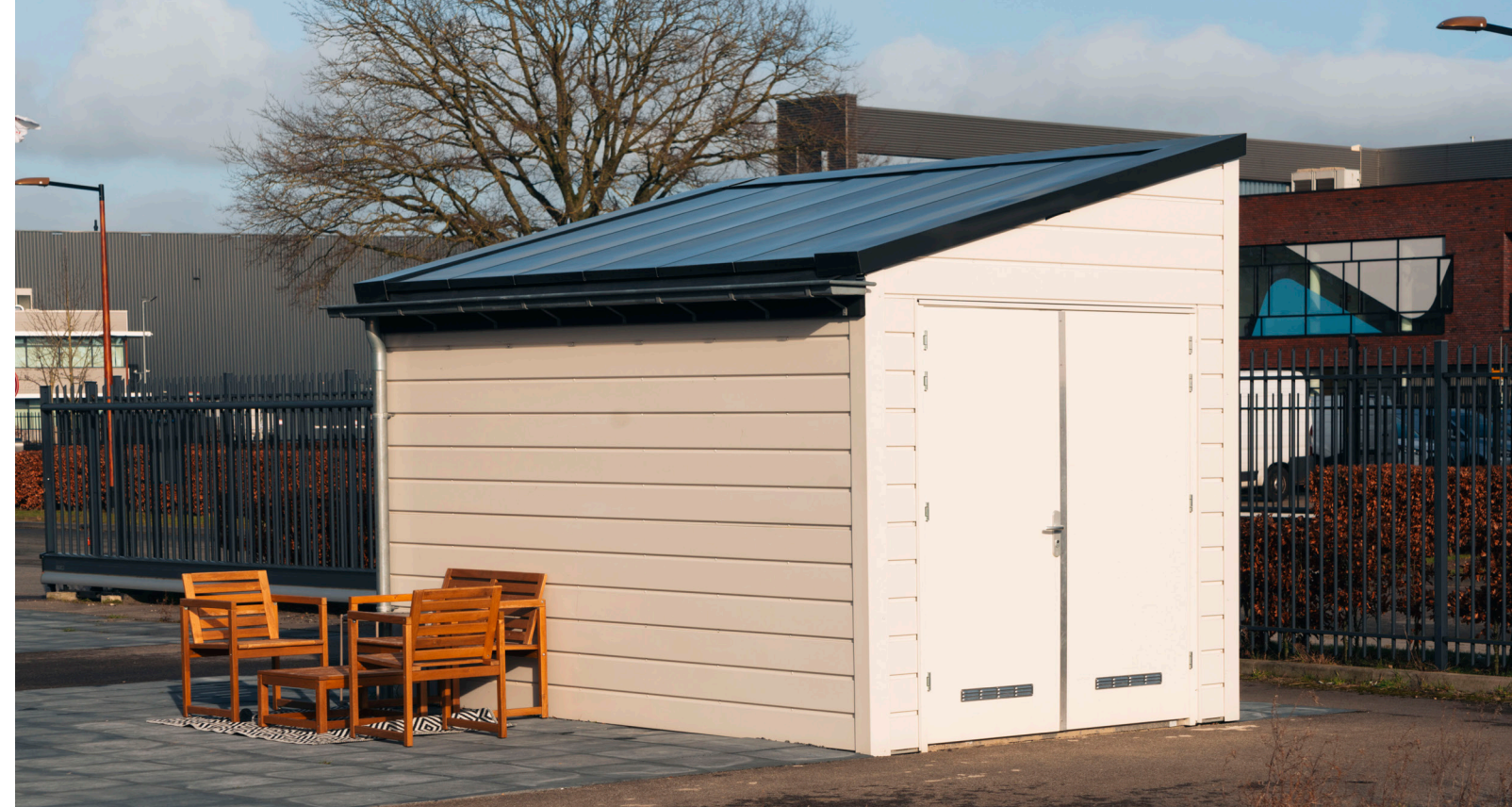
▲ ENERGIEBERGING UITGEVOERD IN WIT MET RECHTS DE DEUREN NAAR DE TECHNISCHE RUIMTE
