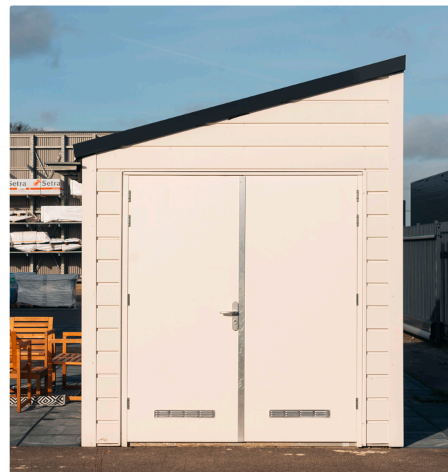
▲ DE TWEE DEUREN NAAR DE TECHNISCHE RUIMTE
